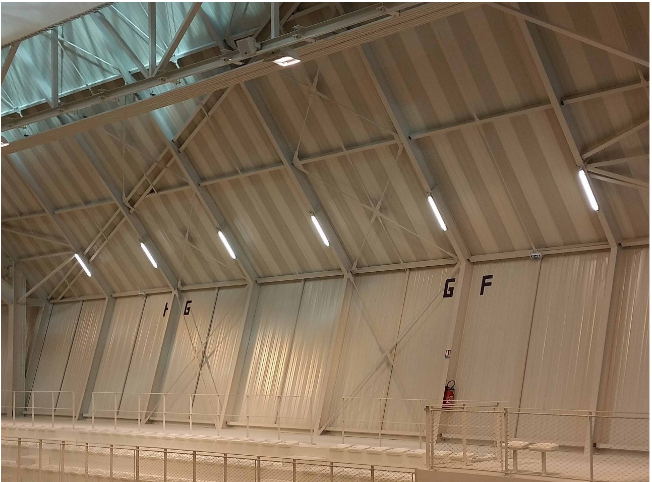
J1 25-125-1000 Wand in einer Sporthalle.
