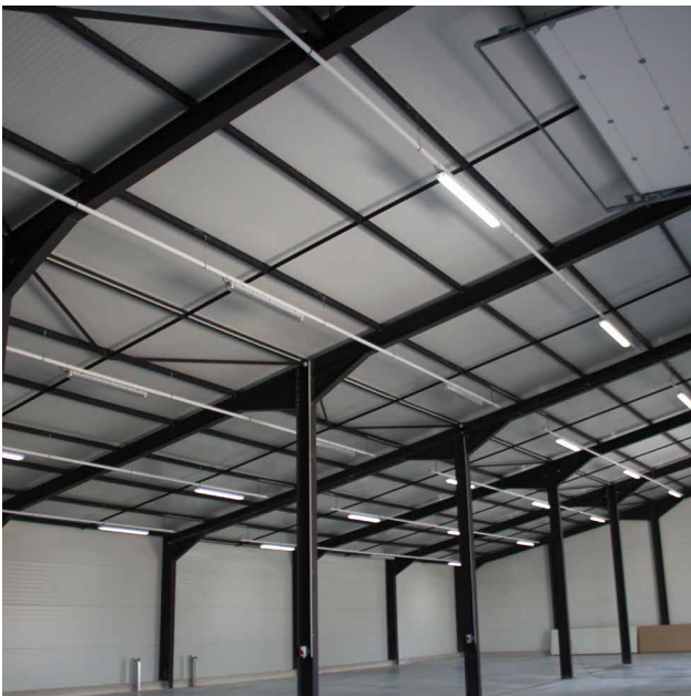
Industriegebäude, Konstruktion und Hülle mit JI.
