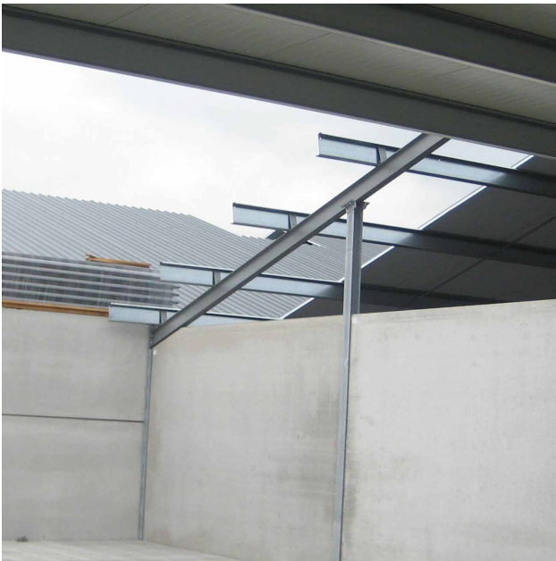
Montage von Strukturprofilen.
