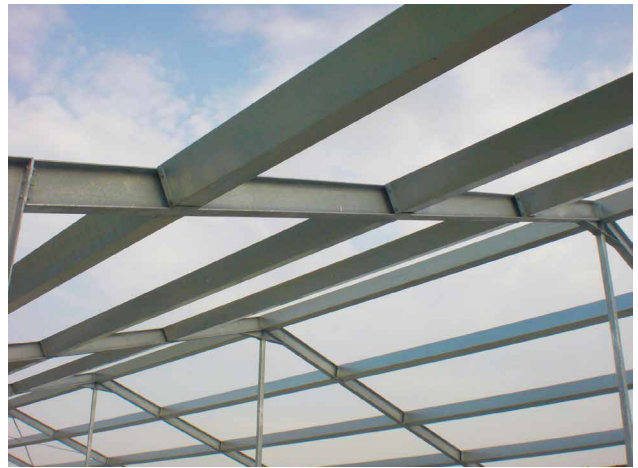
Industriegebäude in der Montagephase.
