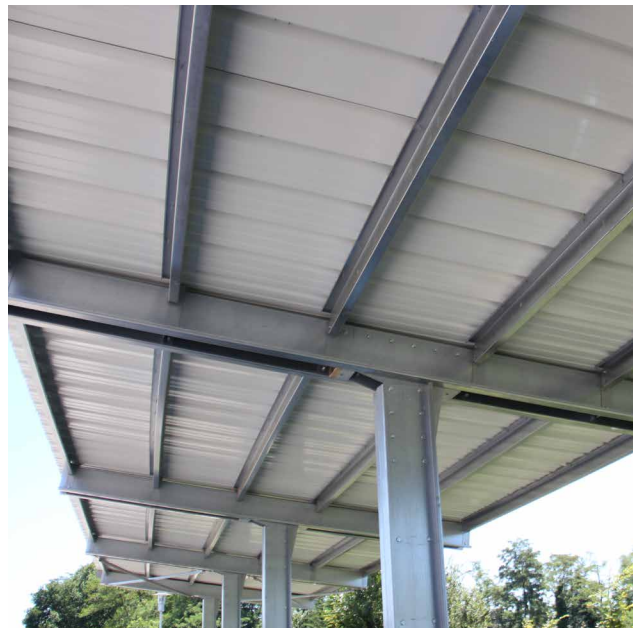
Carport, hergestellt mit verzinkten JI-Profilen.
