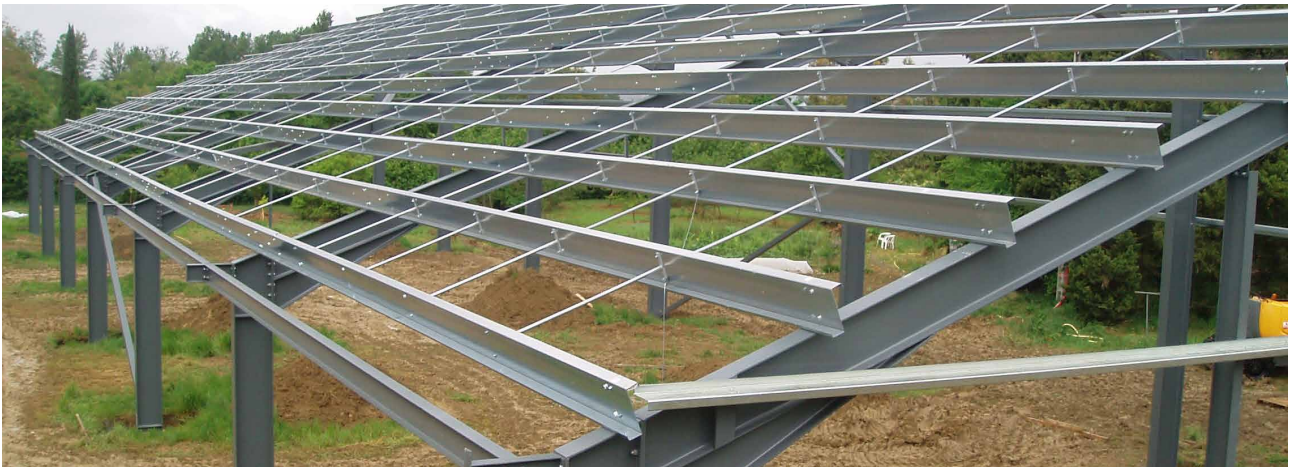
Lagerhalle in der Montagephase.
