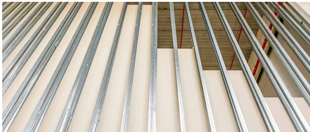
Metalständerkonstruktion für die Errichtung von Trennwänden.
