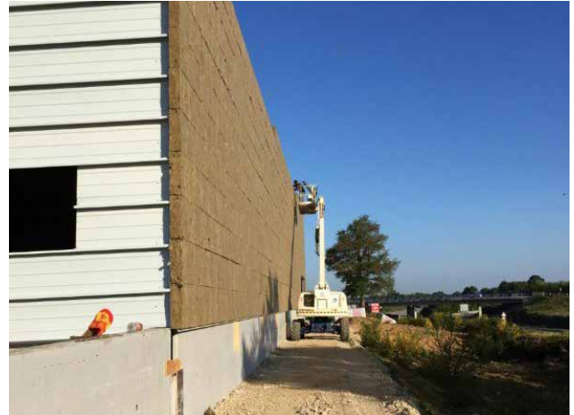
Die Kassetten werden verlegt.
