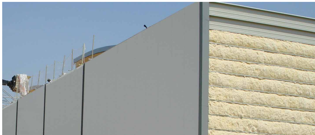
Verlegen von Kassetten.
