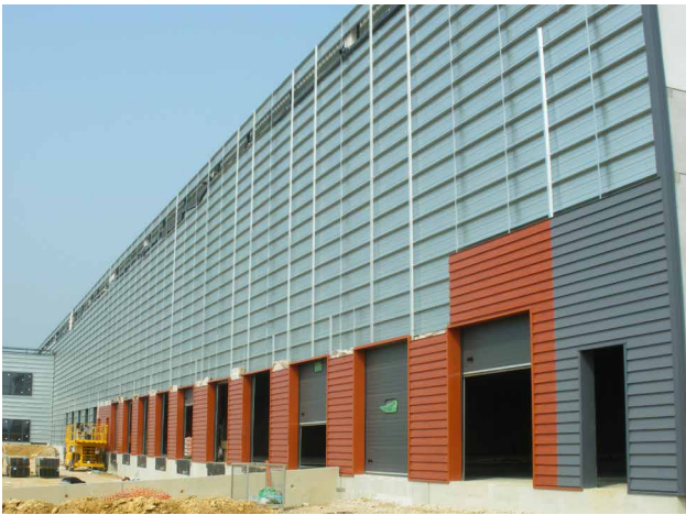
Doppelte Verkleidung für ein Logistik-Lager.
