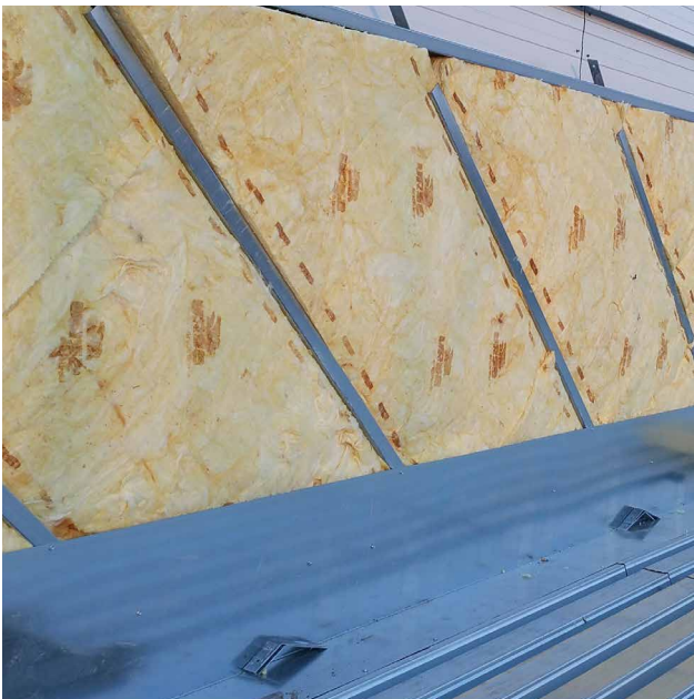
In der Industrie eingebaute Verkleidungsplatten.
