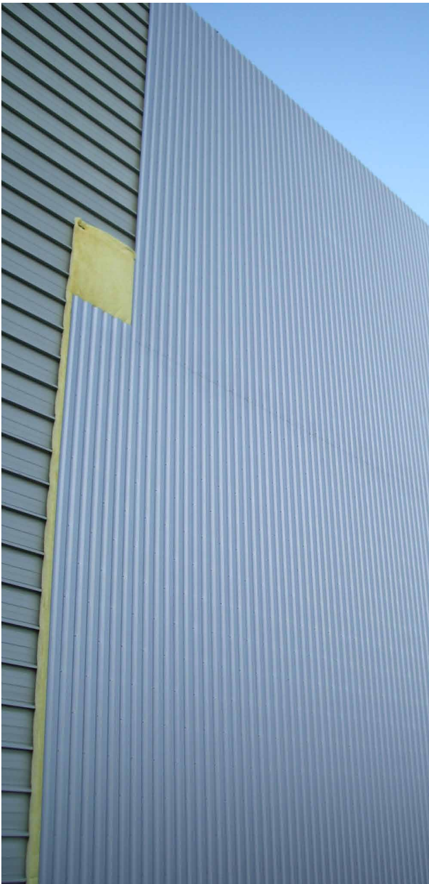
Aufbau der doppelten Verkleidung.
