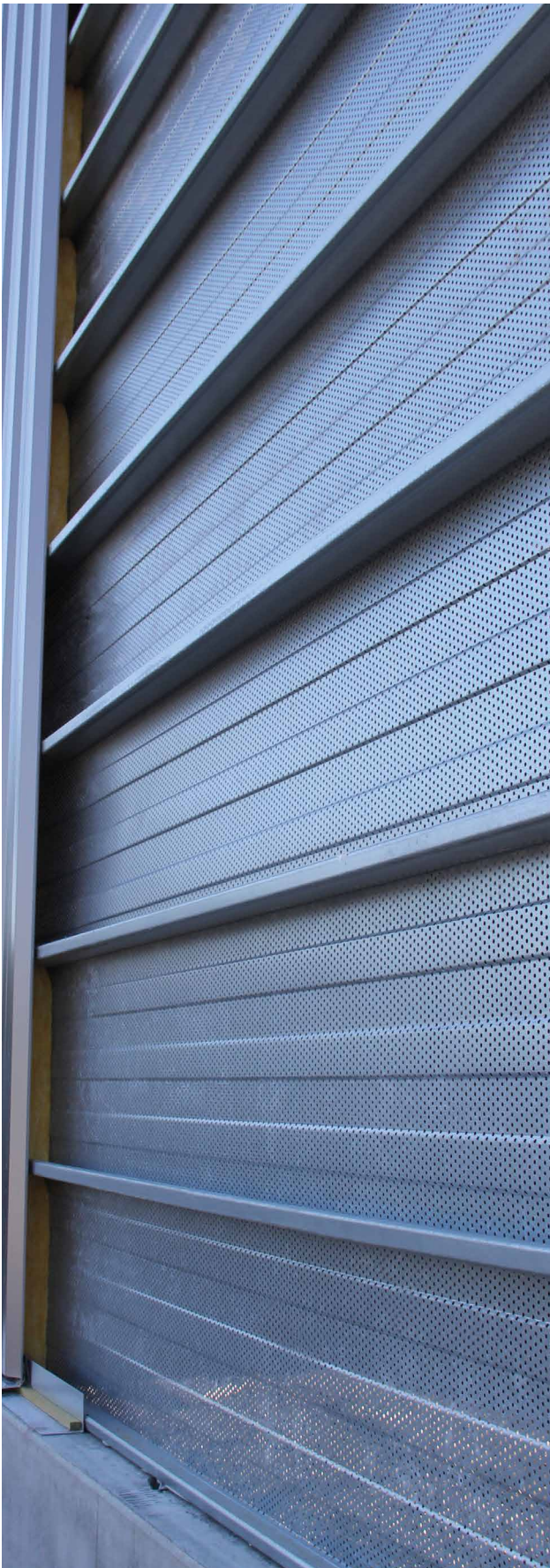
Doppelte Verkleidung mit Kassette und Profil.
