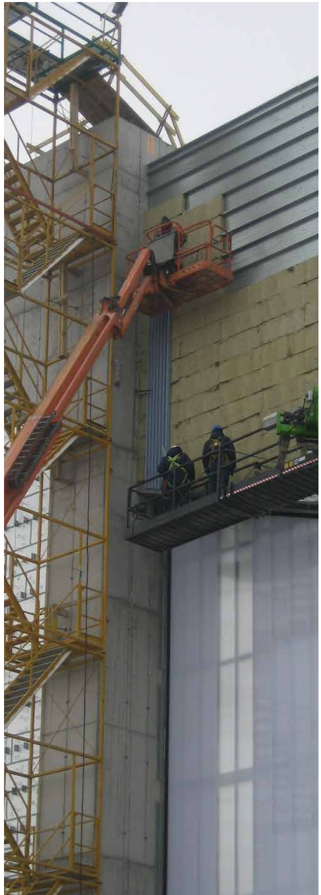
Installation der Verkleidungsplatten für eine industrielle Plattform.
