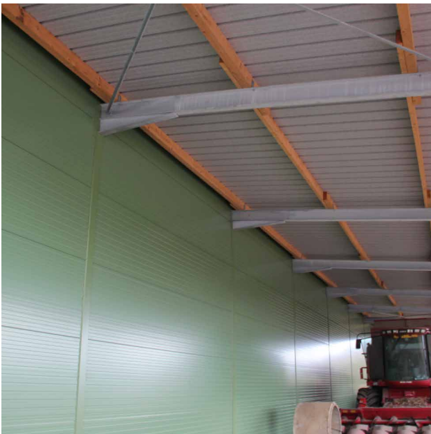
Landwirtschaftliches Lagergebäude mit JI Wall PIR.
