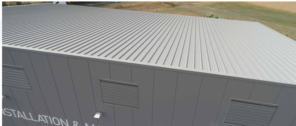
Jl Roof PIR für die Überdachung eines Industriegebäudes.
