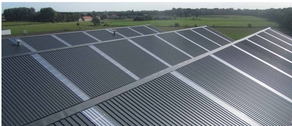
Montage von JI 45-333-1000 mit transluzenten Paneelen.
