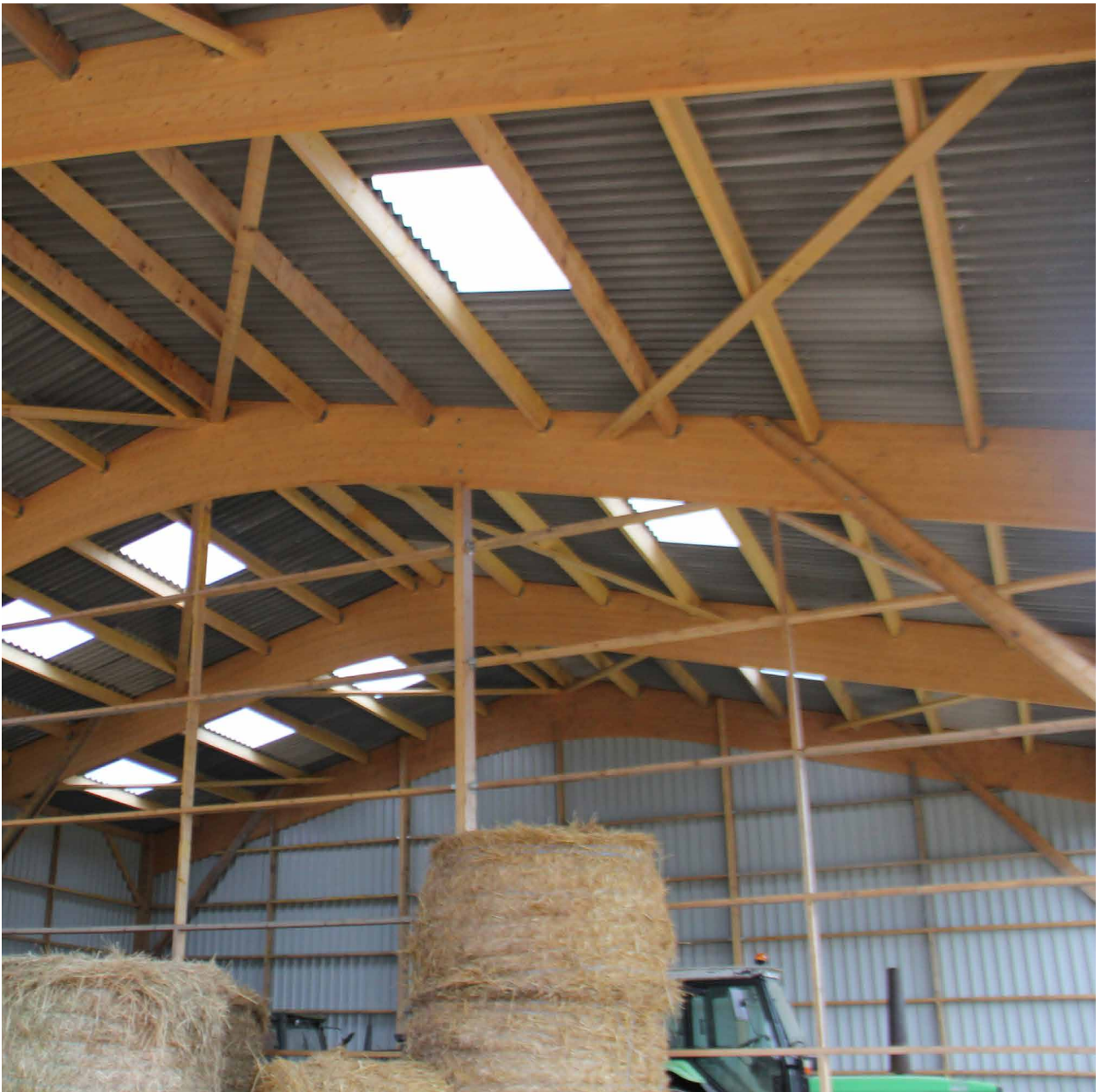
JI 35-207-1035 Dach auf Holzunterkonstruktion.
