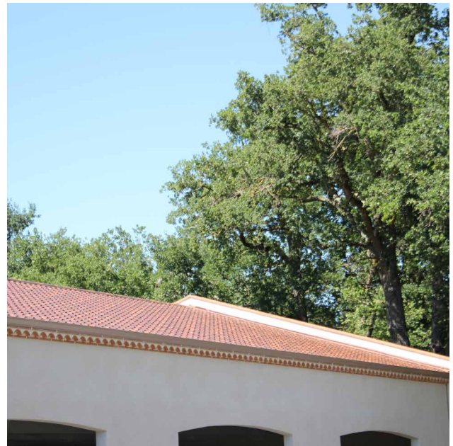
Ranch mit JI Permapan PIR, Cloudy Terrakotta.
