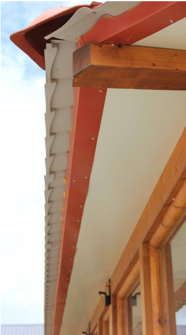
Isolationsschutzprofile für Paneele zur Abdichtung.
