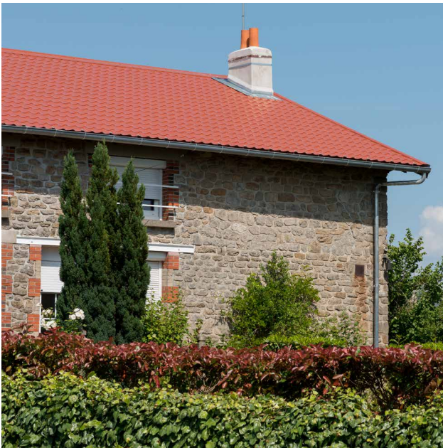
Realisierung mit JI Permapan PIR, Terrakotta.
