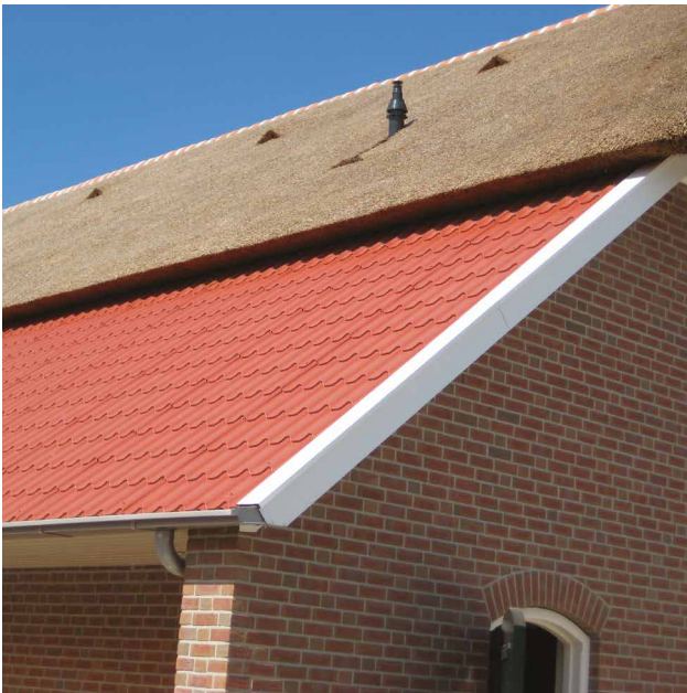
Wohnbau, renoviert mit Dachfannenprofilen.
